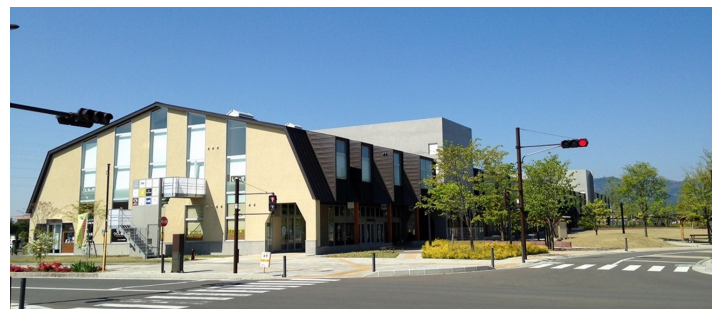
木造施設 オガールプラザ
